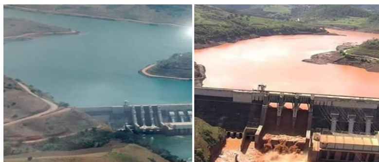
Figura 6 – Antes e depois da lama - Usina Hidrelétrica Risoleta Neves
