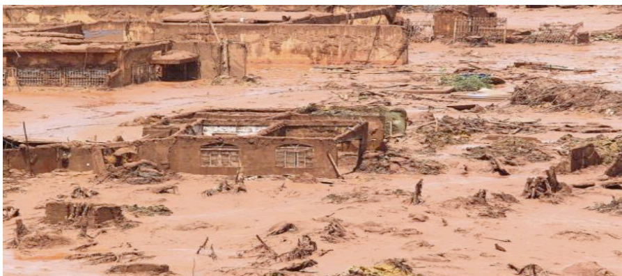
Figura 7 – Destruição de Bento Rodrigues
