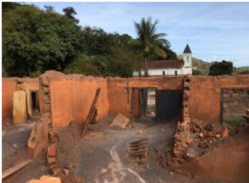
Figura 5: Gesteira após o desastre de Fundão
