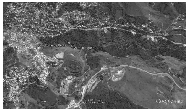
Figura 2. Cavidades do Vale do Ojô (Ponte de Pedra e Fogão), localizadas próximas à área urbana de Ouro Preto. Despejos constantes de lixo e esgoto constituem seus principais impactos antrópicos.
